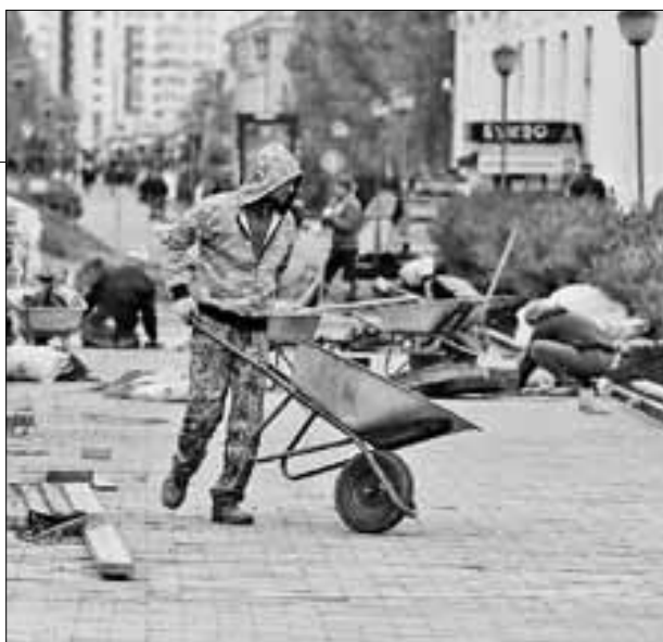
■ На Чумбаровке темп работ по укладке брусчатки высокий, подрядчик спешит уложиться в сроки. ФОТО: ИВАН МАЛЫГИН
