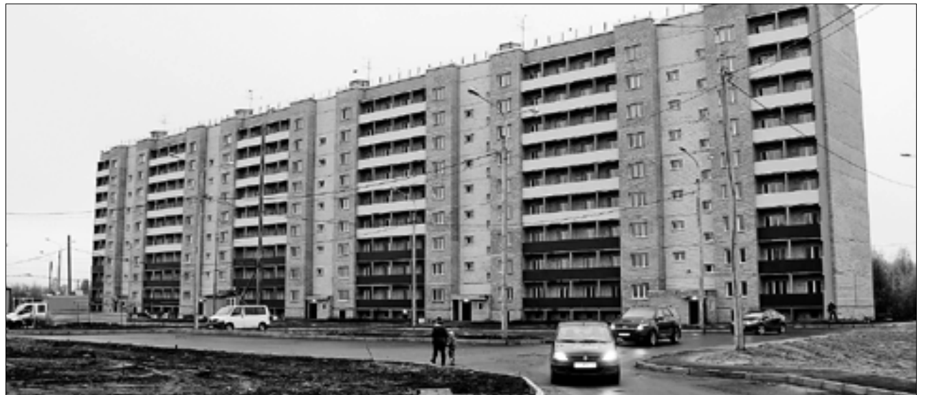
■ Первые жильцы дома на Карпогорской, 32 уже получают ключи от новых квартир. ФОТО: ПРЕСС-СЛУЖБА ГУБЕРНАТОРА И ПРАВИТЕЛЬСТВА ОБЛАСТИ
