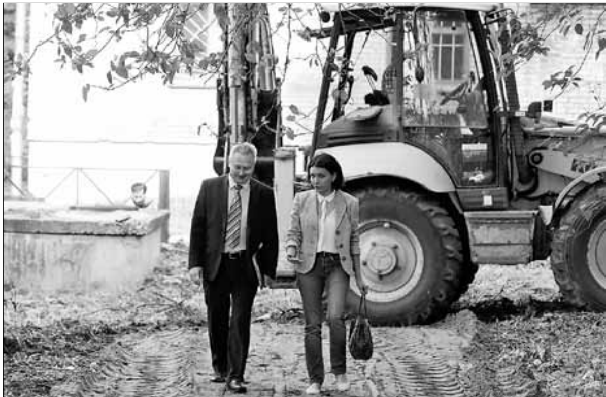
■ Петр Чечулин и Елена Слободянюк осматрели объект и обсудили ход работ
