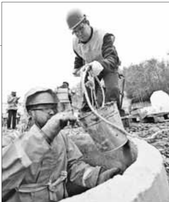
■ Четко, быстро и по инструкции работали бригады канализационных сетей
