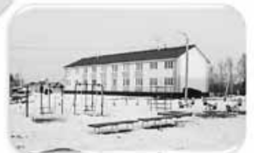
Введены в эксплуатацию три жилых дома по ул. Конзихинской
