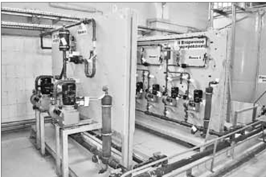
**■ На «Водоканале» установлена система бесхлорного обеззараживания воды**
