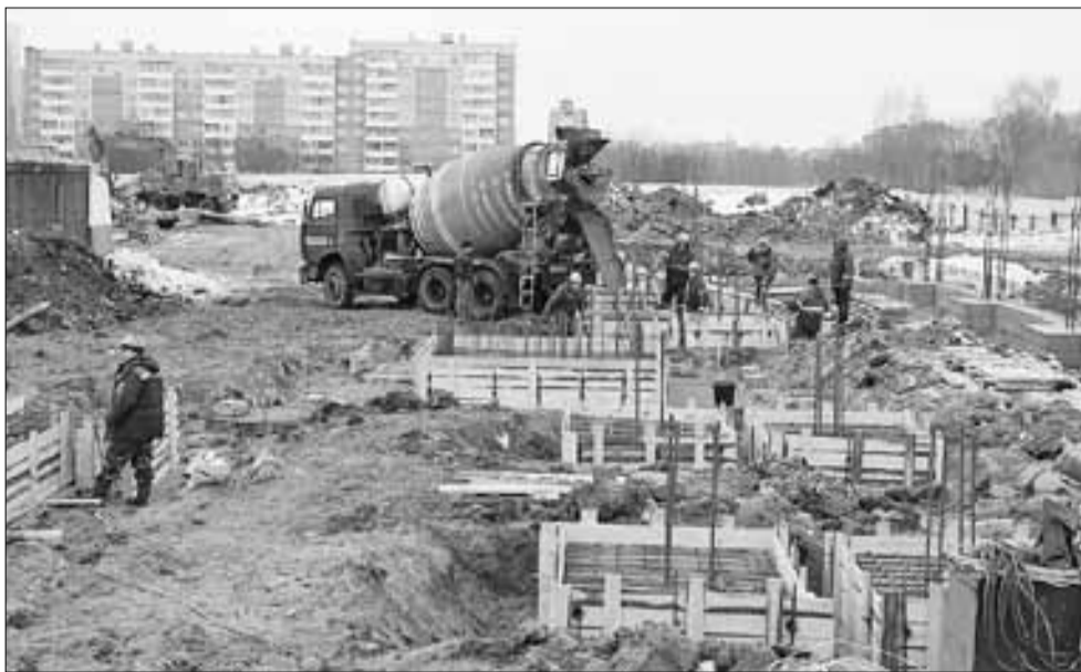
■ На стройплощадке на Ленинградском проспекте рабочие заливают ленточный фундамент будущего дома. ФОТО: ПРЕСС-СЛУЖБА АДМИНИСТРАЦИИ ГОРОДА
