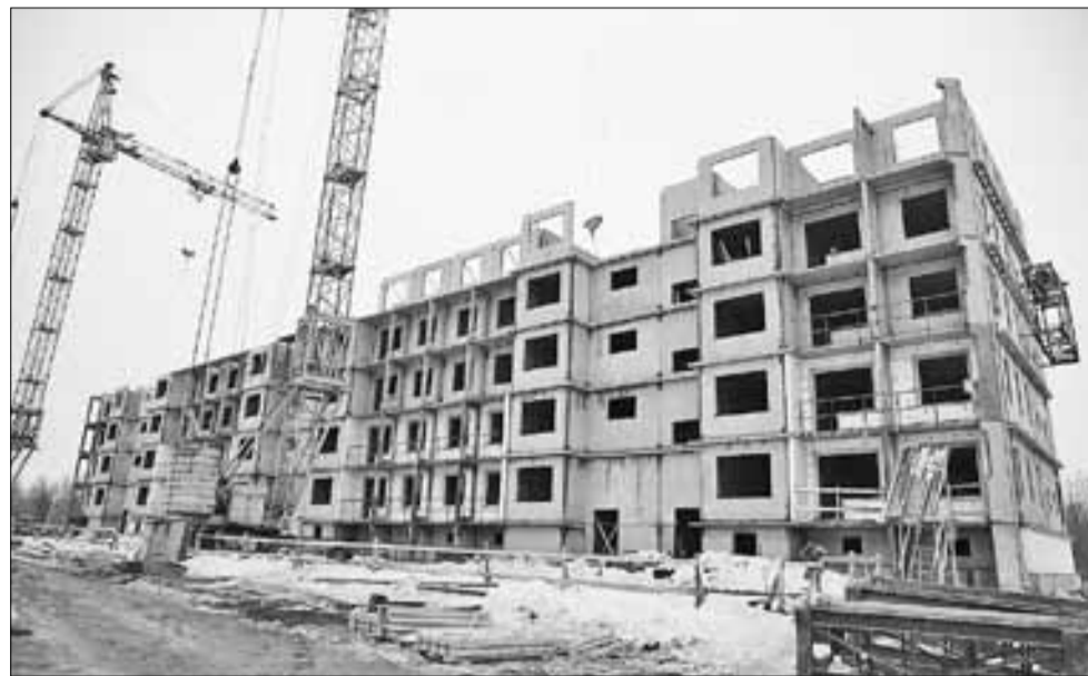
■ Социальный дом на Московском проспекте уже возведен до пятого этажа. ФОТО: ПРЕСС-СЛУЖБА АДМИНИСТРАЦИИ ГОРОДА
