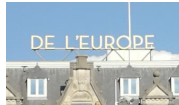
Хорошо. Крышная установка без подложки
