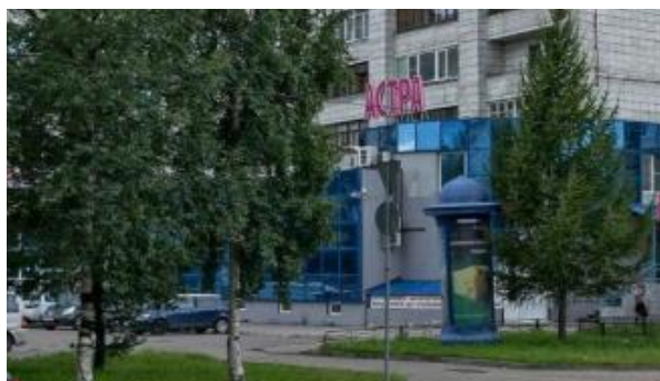
Плохо. Крышная установка находится на здании ниже 12 м
